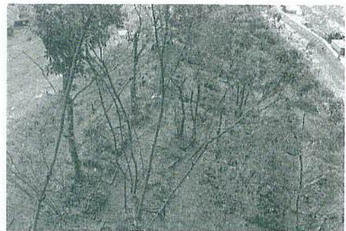
図3 造成中ののり面に移植された林床ブロック
