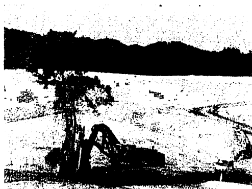
図6 重機による高木移植
